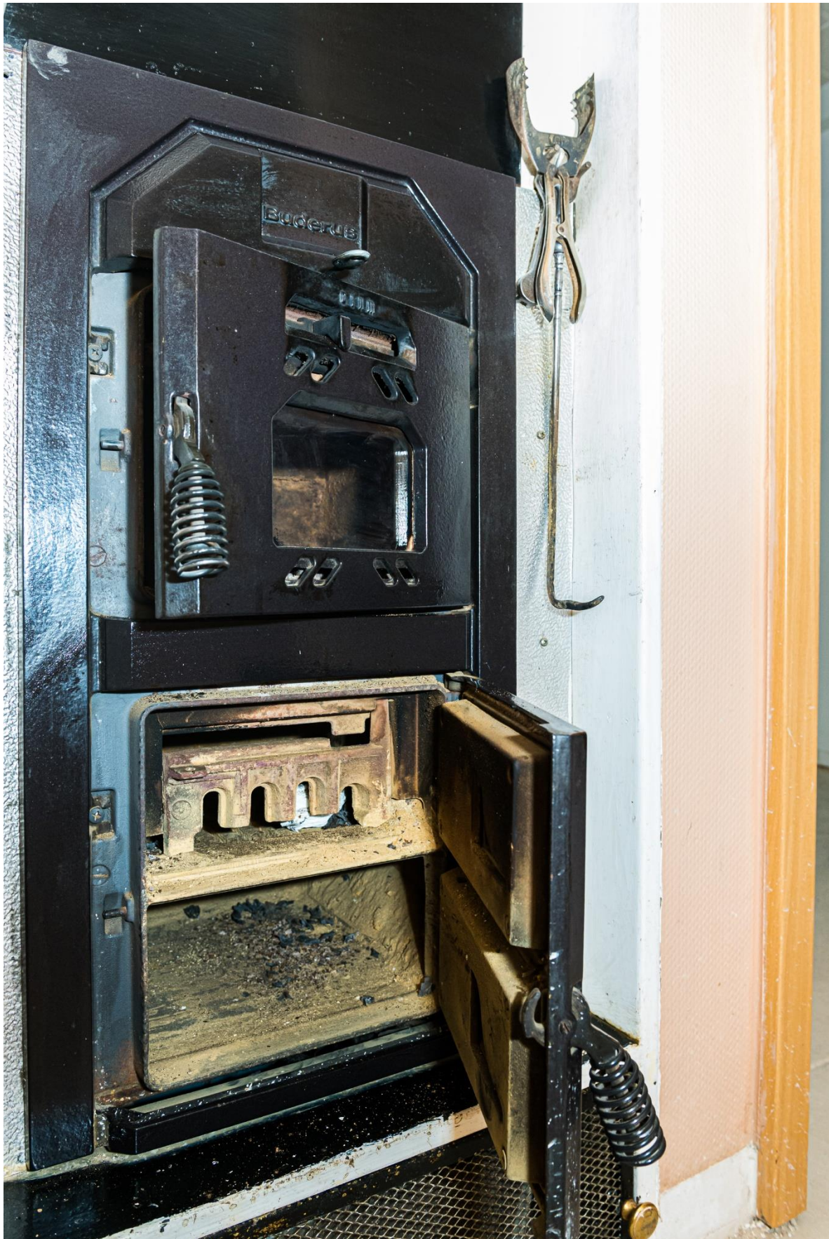
Einer von 64 Kohleöfen die stillgelegt werden
