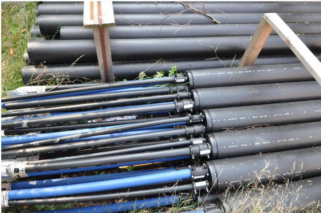
Bild 2 o Das Sondenfeld je Wohnblock umfasst 18 Vertikal-Sonden à 32 m.
