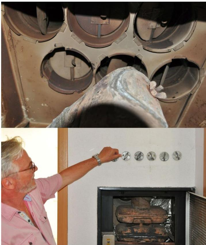
Bild 9 o Die Heizleitungen zum Klimakonvektor verstecken sich in den schmalen Leitungsschächten unter der Decke und an der Wand
